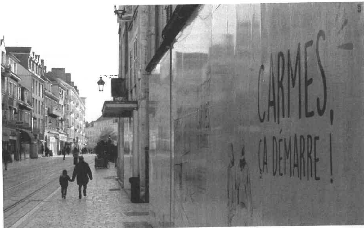
Le chantier de transformation urbanistique du quartier Carmes a commencé. Suffisant pour faire reculer les problèmes d'insécurité ?
